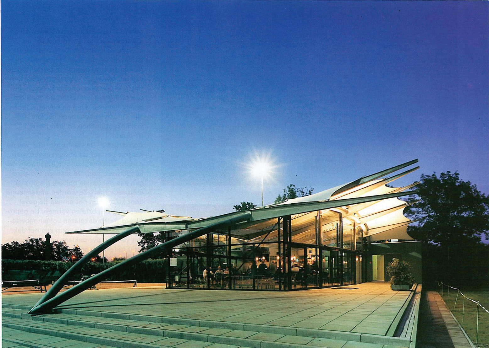
Het van onder aangelichte luifeldoek doet ook dienst als terrasverlichting. Uit het zuiden.
