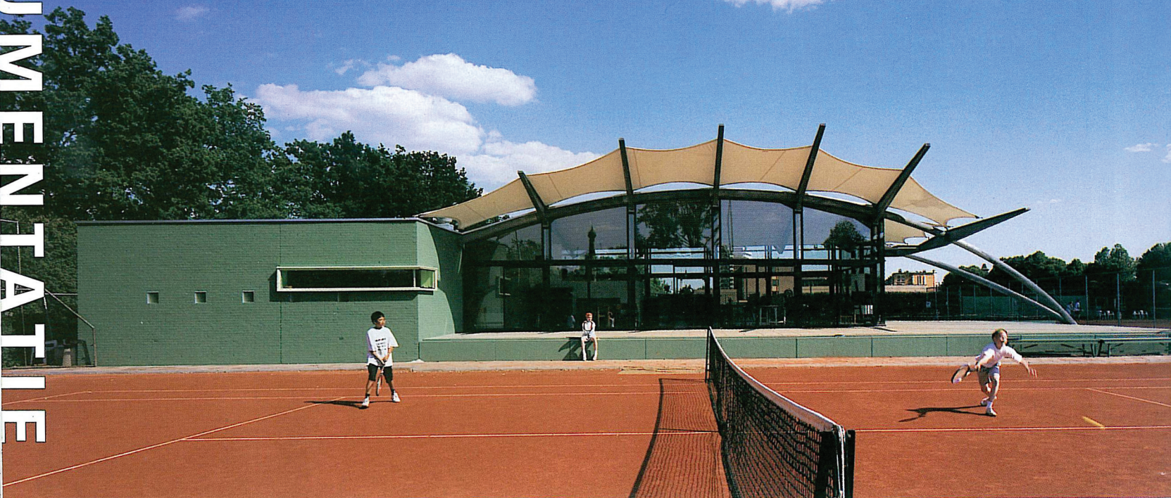
Het tennispaviljoen als een exotische hagedis tussen de gravelbanen. Uit het westen.
